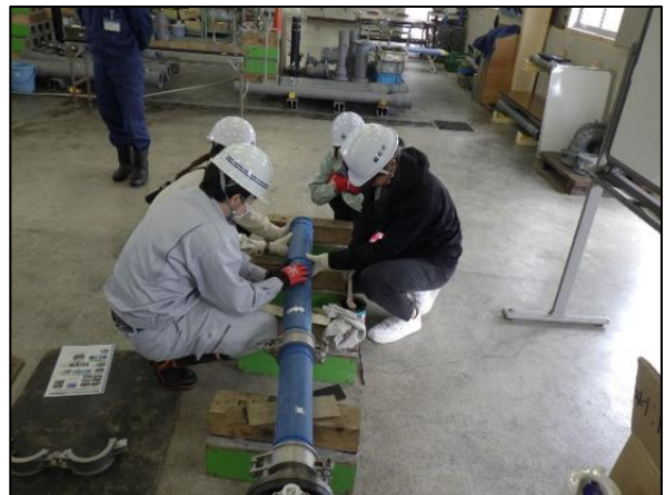
■レンタル管の接合（配ポリタイプ）
