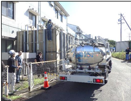
■①市民病院受水槽への応急給水作業
